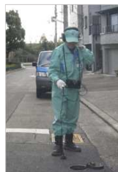
漏水調査の様子
