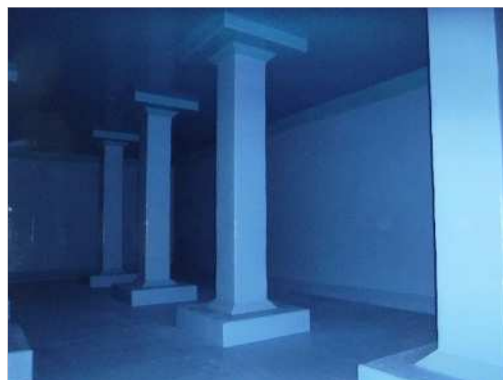
配水池の内面
