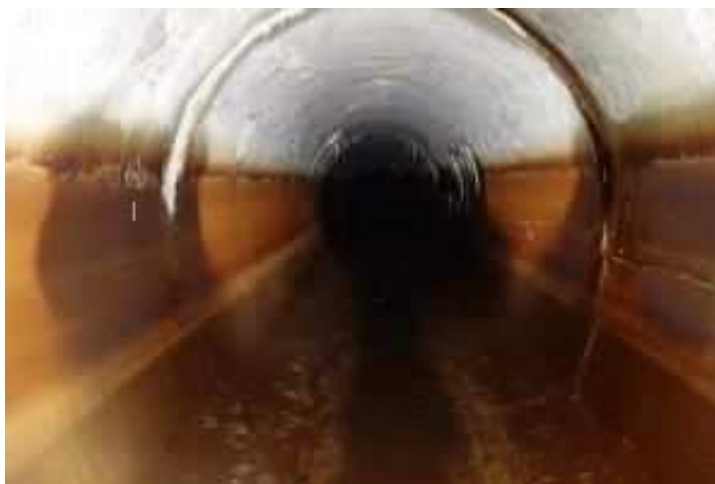
4 拡送水トンネル内部の状況
