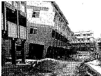
杜子社區の建物倒壊
