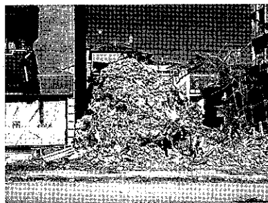
瓦礫が撤去されないまま放置されている（イズミット市）
