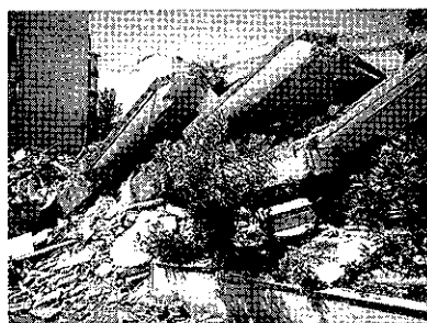
パンケーキ状に重なって完全崩壊している建物が目立った（イズミット市）
