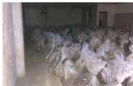
除去したアスベストは他の廃棄物と混ざらないようにし、プラスチック袋（透明）につめ、飛散、流出ないように密封します。袋詰めしたアスベストは指定された場所に集積します。車両積み込み時は袋の損傷がないように原則人力で積みます。
