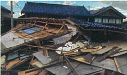
▲ 輪島市における倒壊家屋
