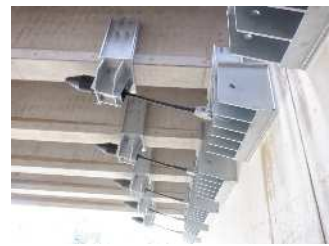
＜橋の耐震補強工＞
