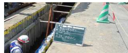
《水道管の耐震化》
