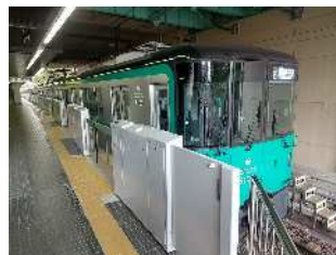
《ホームドアの設置》
