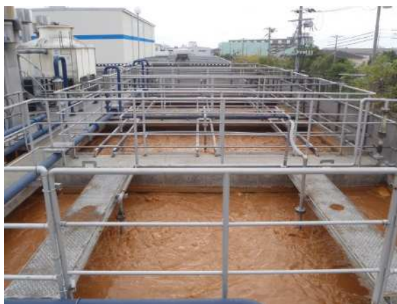
図 16 生物処理の例 (産業排水の活性汚泥処理)
