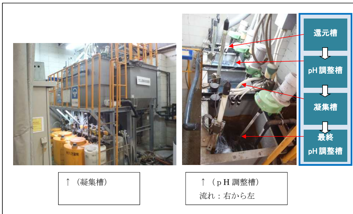
図 10 六価クロム前処理の例
