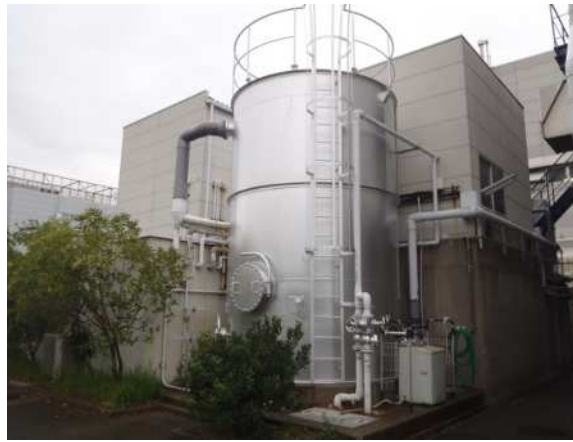
図 14 接触酸化塔 (外観)
