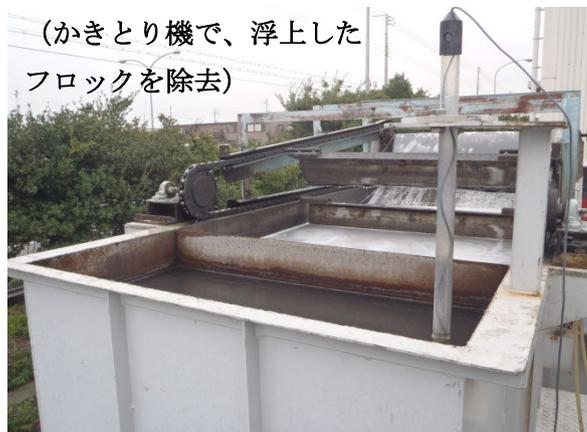
図 12 凝集加圧浮上装置
