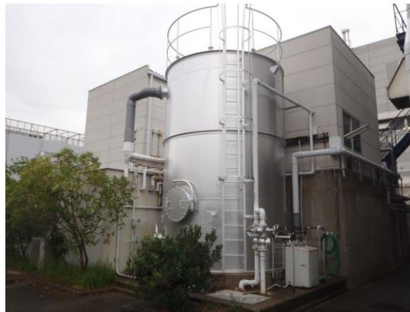
図 14 接触酸化塔（外観）
