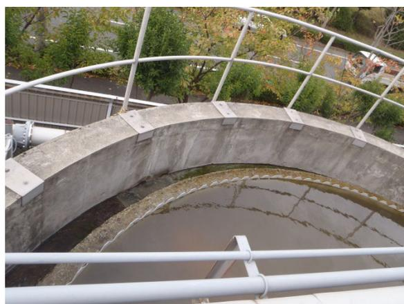
図 17 生物処理の例 (産業排水の活性汚泥処理)
