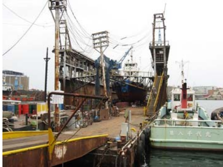
・浮ドックでの造船の様子（西出町）
