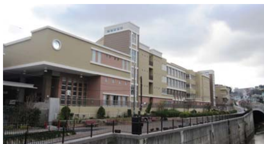
夢野の丘小学校（完成新校舎） 平成22年12月完成
