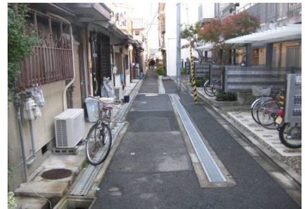
・建替により、建物が後退し道路が広がっています
