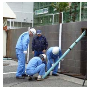
・防潮堤鉄扉閉鎖作業
