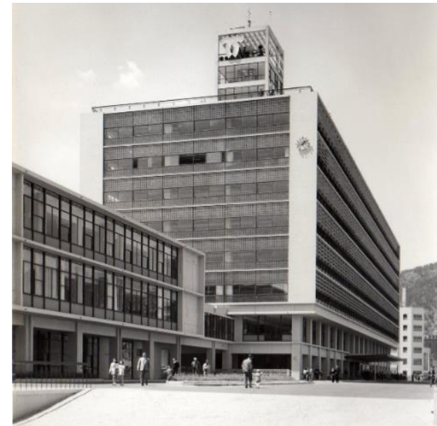
旧2号館・議会棟 （昭和32年（1957年）竣工）
