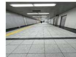
▲地下鉄ハーバーランド駅 (清掃後)
