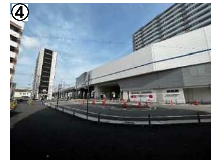
④ 深江駅北側広場暫定供用中
