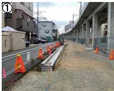
① 魚崎地区側道工事中
