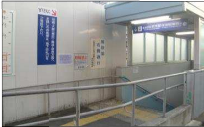
駅舎出入口(整備前)
