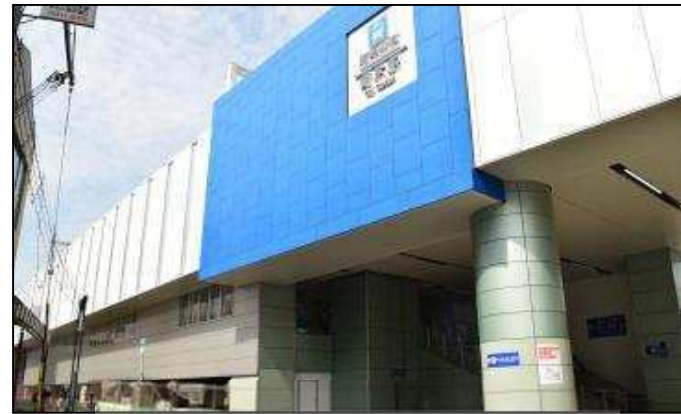
駅舎外観(整備後)
