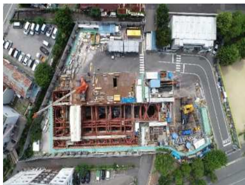
新東川崎ポンプ場整備(中央区)
