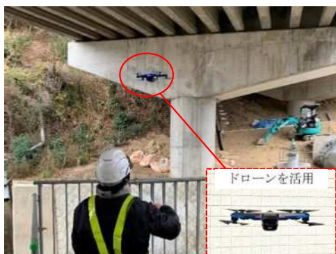
橋梁点検（北区 地藏橋）
