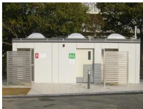
公園トイレチェンジアクション (西区 狩場台公園)
