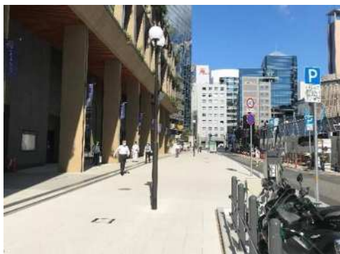
東町線（中央区役所前）
