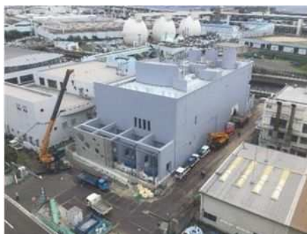
魚崎ポンプ場改築更新事業 (第1期) (東灘区)
