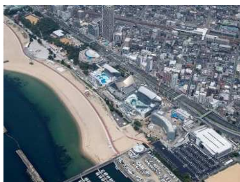
工事状況（令和5年6月時点）
