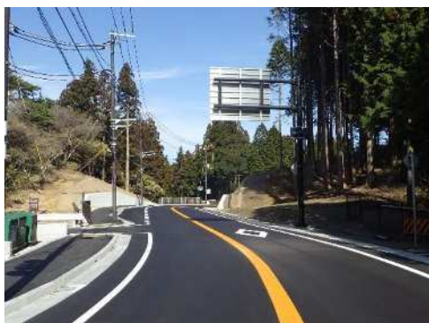
明石神戸宝塚線の歩道整備 (I期工事完成状況) (灘区 六甲山町)
