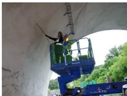
トンネル点検（須磨区 多井畑トンネル）
