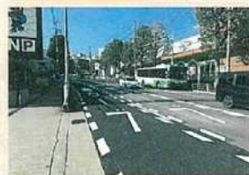
▲減速マーク、路面表示(西行、東行共)の設置
