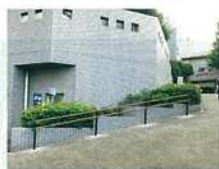
坂道での手すり設置
