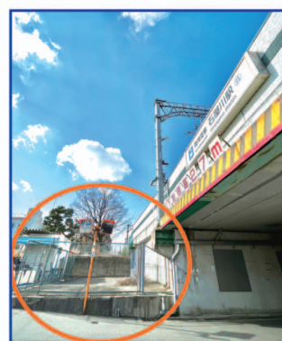
㉔ 阪神石屋川駅の新設予定地
