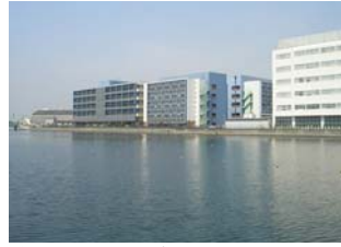
復興ものづくり工場、 運河沿い企業
