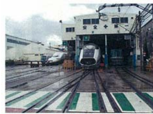
川崎重工業 兵庫工場
