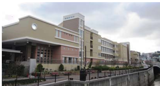
夢野の丘小学校（新校舎） 平成22年12月完成
