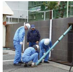
・防潮堤鉄扉閉鎖作業
