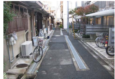
・建替えにより、建物が後退し道路が広がっています
