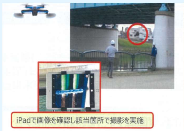
ドローンを活用した点検 ○
