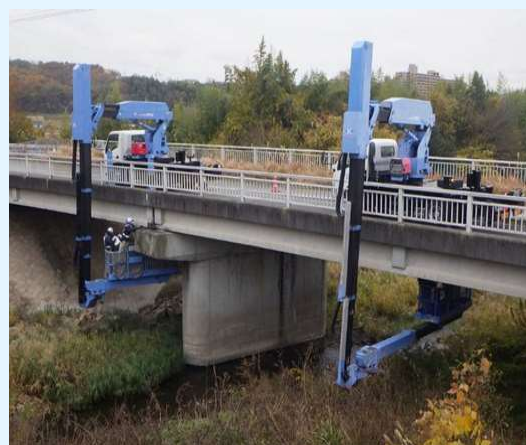
高所作業車を活用した目視点検 ○
