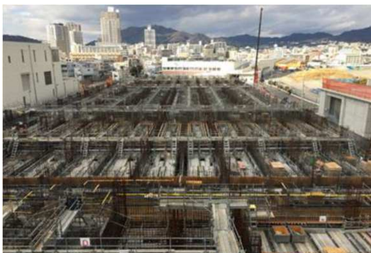
西部処理場北系整備
