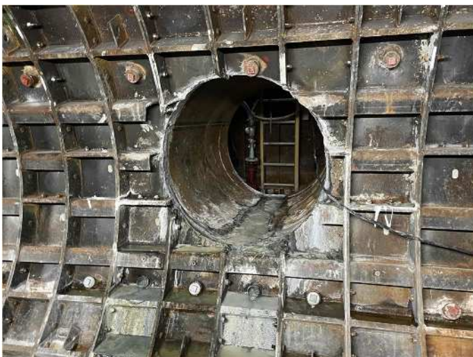
③雨水幹線への取込管（中間立坑から推進工法で施工しています）
