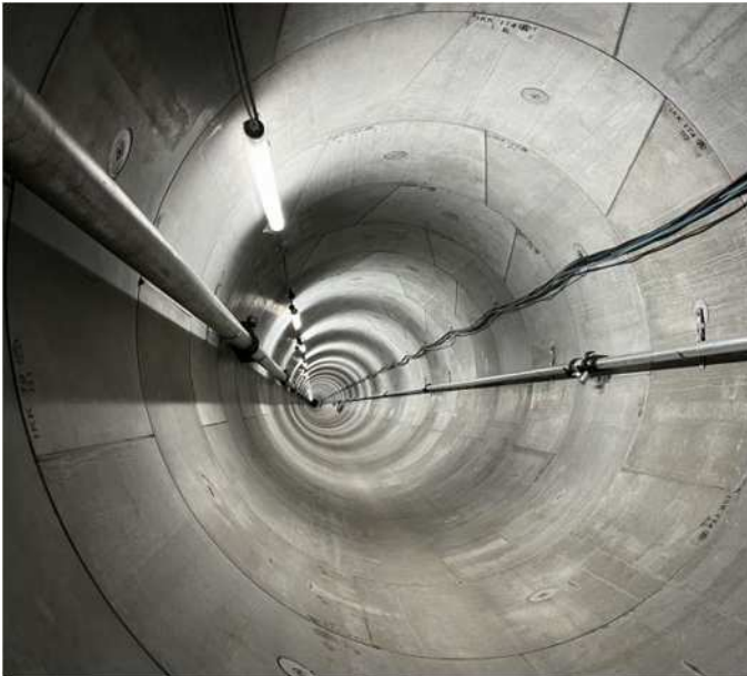
③雨水幹線への取込管（中間立坑から推進工法で施工しています）
