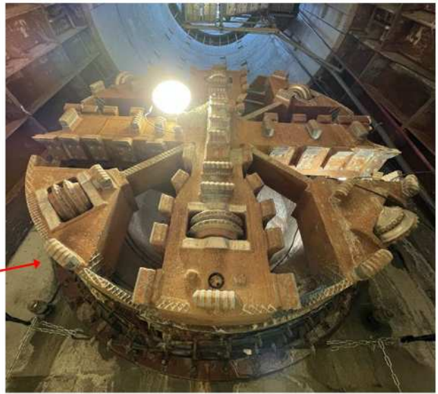
①雨水幹線（2023年11月、掘削が完了し到達立坑にシールドマシンが顔を出しました。）
