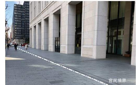
▲ 歩道部と共通した舗装の使用例（本町ガーデンシティ）
