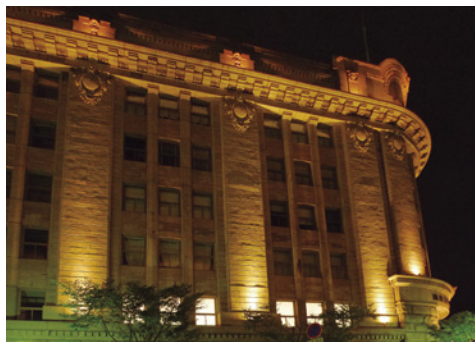
▼ ファサードを生かした照明演出 (商船三井ビル)
