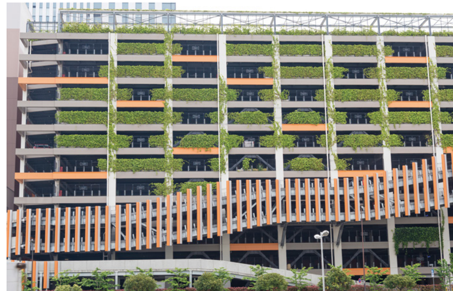
▼ 立体駐車場の緑化修景の例
