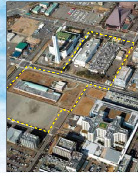
ポートアイランド処理場
