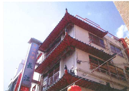
反りのある庇を各階に繰り返し取り付けすることで、陰影のある個性的な景観にすることができます。
