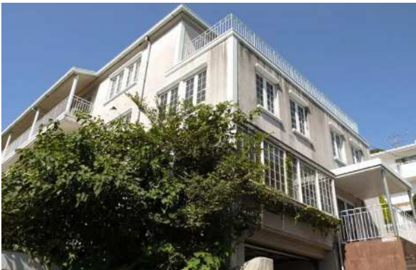
外観を細やかにデザインすることは、大きな建物を小さくみせる上で有効です
