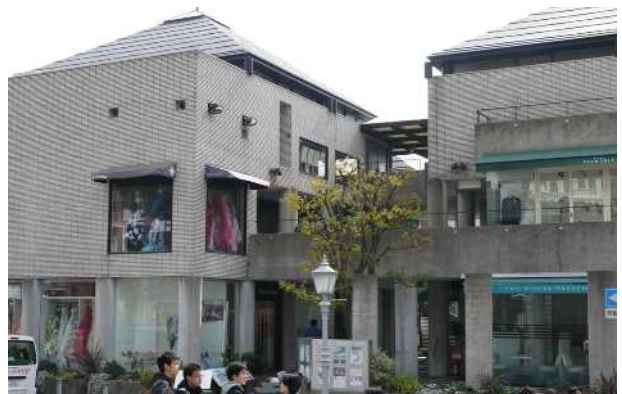
建物を分棟することで、小さく見せることができます
