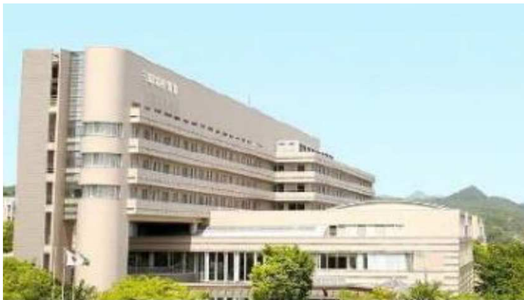
図 3-1 三田市民病院の外観
