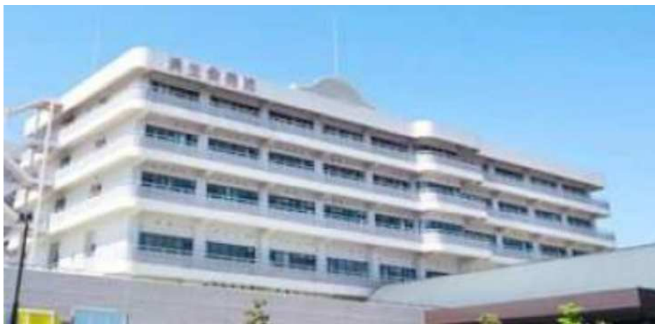
図 2-1 済生会兵庫県病院の外観
