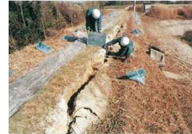
写真-1 堤体亀裂状況
