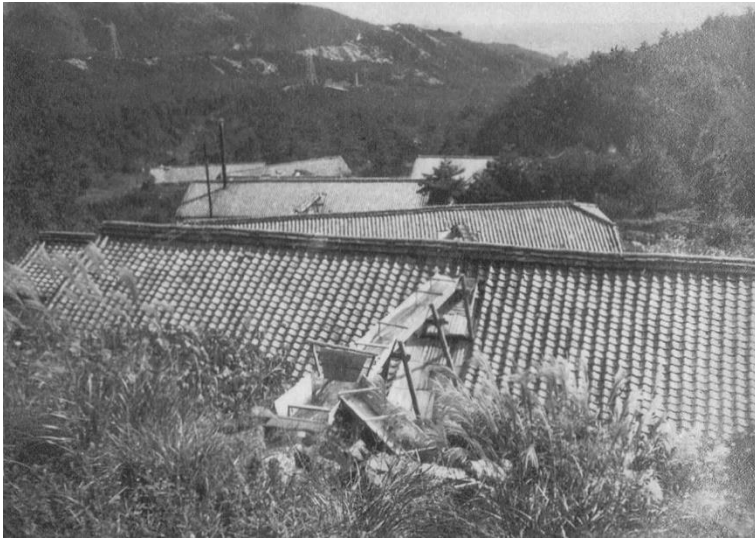
参考) 西谷川上流域水車小屋（住吉歴史資料館蔵）※水車小屋への導水の状況がわかる
