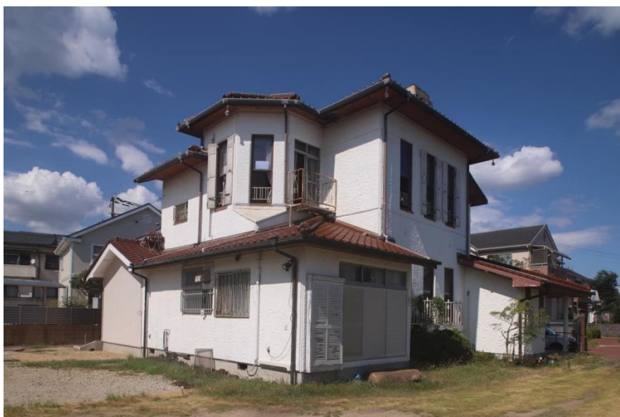
現況写真 (南西から) 撮影:中尾嘉孝
