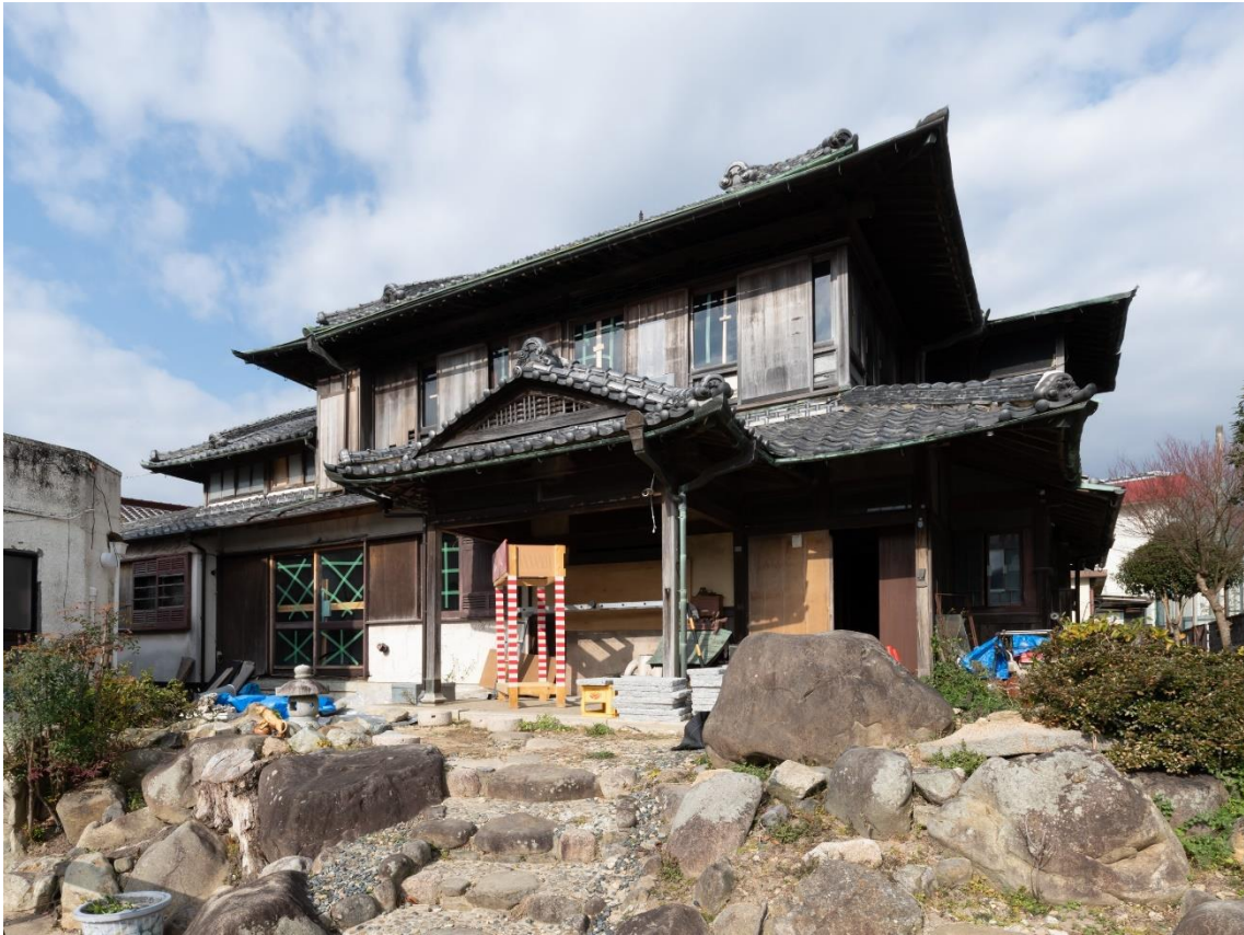
現況写真：松森医院本医院棟（正面玄関・南側）
