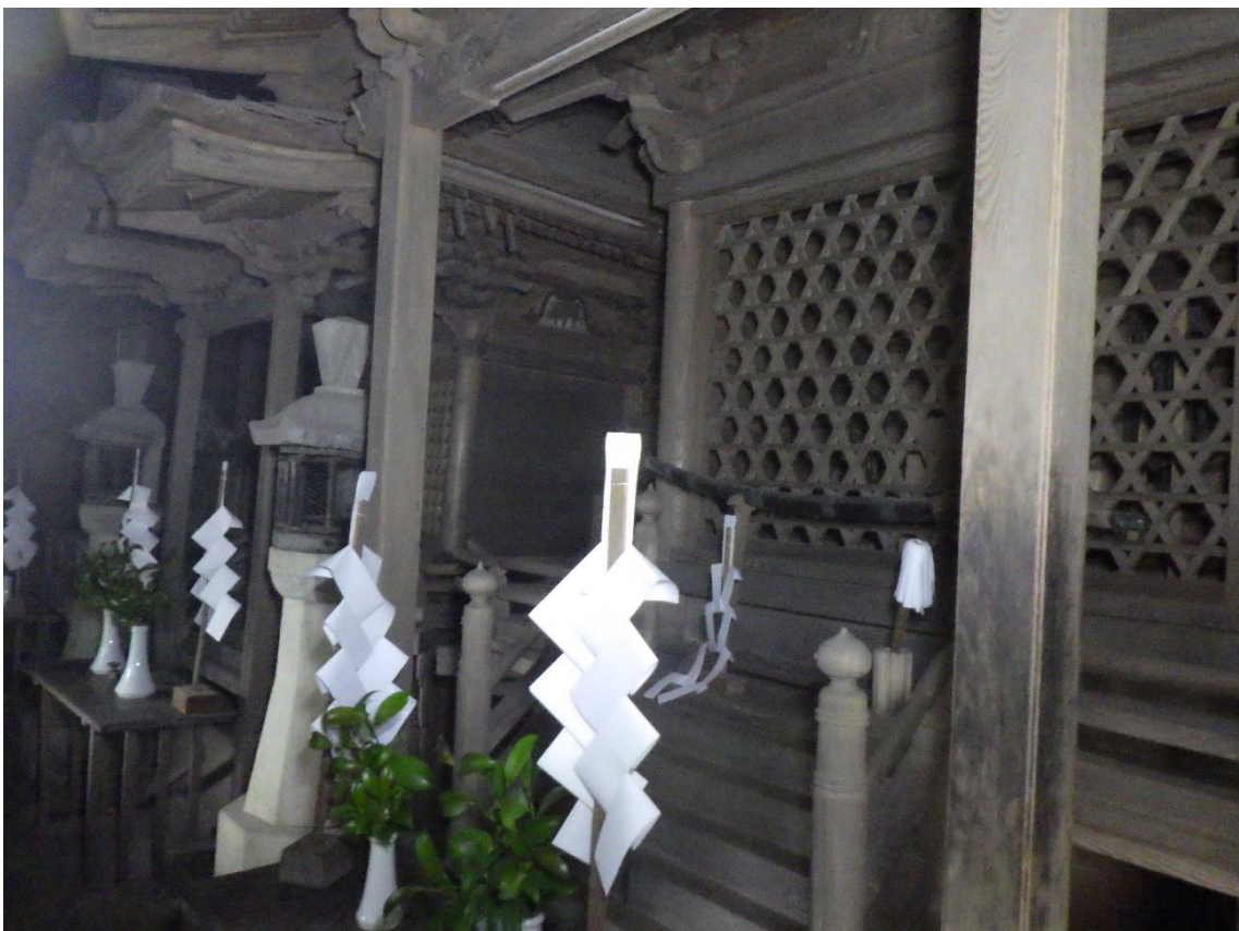
白川大歳神社本殿：東側社殿（南東から）
