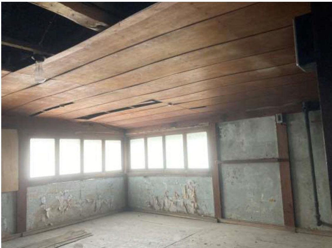
写真：中2階 使用人室
