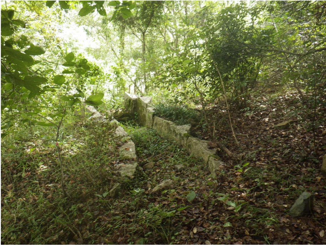
現況写真：②水路跡
