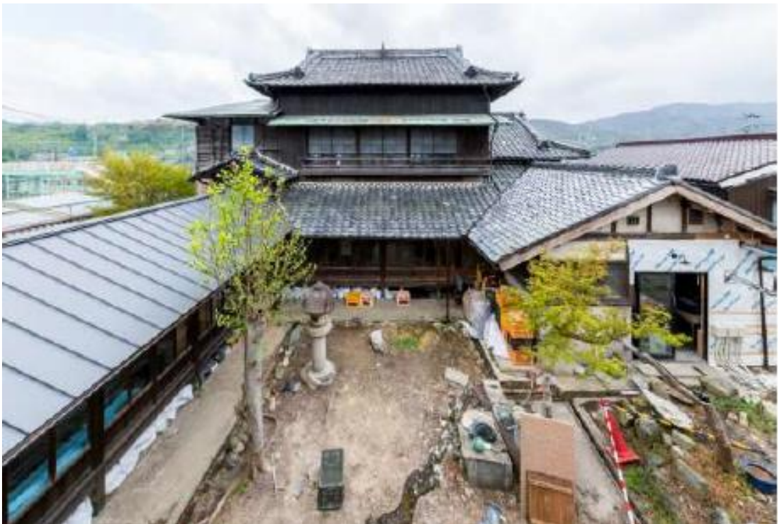
現況写真：松森医院本医院棟（北側）
