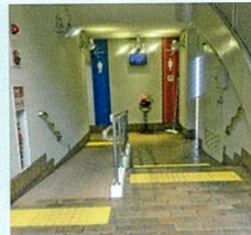
▲トイレのバリアフリー改修
