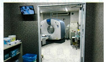
神戸市立医療センター神戸中央市民病院 医療コンテナ型C.T.室
