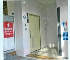
▲多目的トイレの新設
