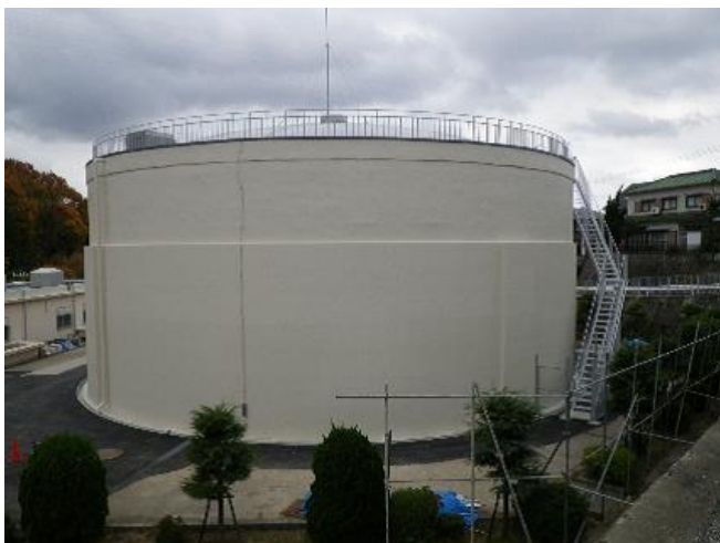
(鈴蘭台配水池)
