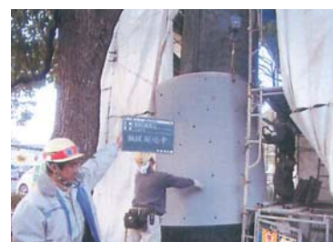
鋼板巻きつけ（ t=12\text{mm} ）
