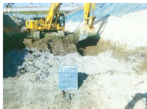
地盤改良状況
