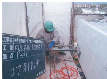
桁座拡幅（削孔）
