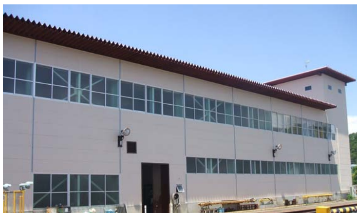
保線作業所(外壁面を塗装改修)
