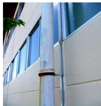
(縦樋・受け金物とも従前のまま)
