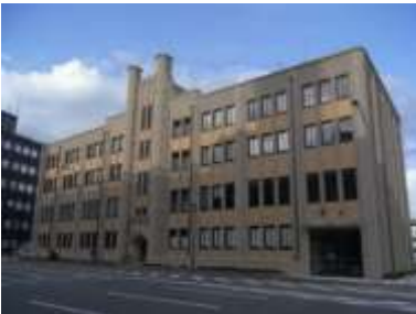
デザイン・クリエイティブセンター神戸 (旧神戸生糸検査所)
