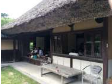
茅葺民家の活用（淡河）
