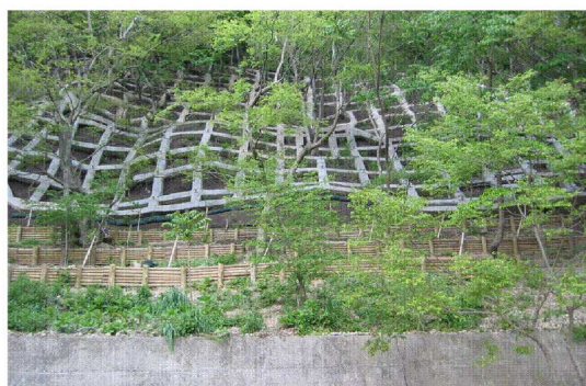
（自然環境に配慮した斜面对策）
