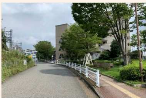
高低差が大きく、歩道幅が狭い
