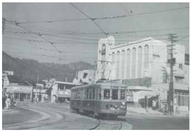
輸送力増強のため市電架線等の施設近代化が図られた
