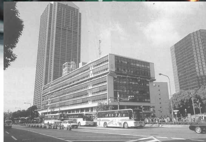
地震によって6階部分が崩壊した神戸市役所2号館と代替バス
