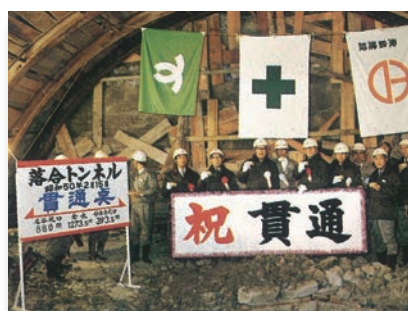
須磨区名谷と妙法寺を結ぶ落合トンネルが開通(昭和50年2月)
