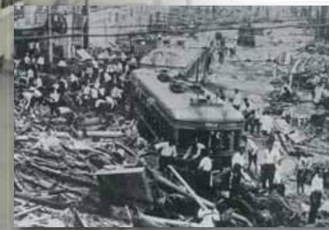
阪神大水害で流木に埋まった市電の復旧作業(当時の三越百貨店前)
