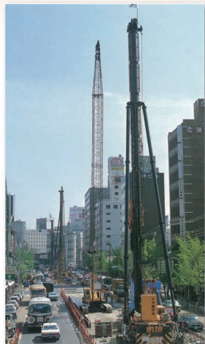
杭打ち用の穴を掘る様子(加納町付近)
