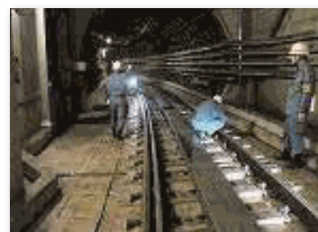
軌道内の重点ハトロールの様子
