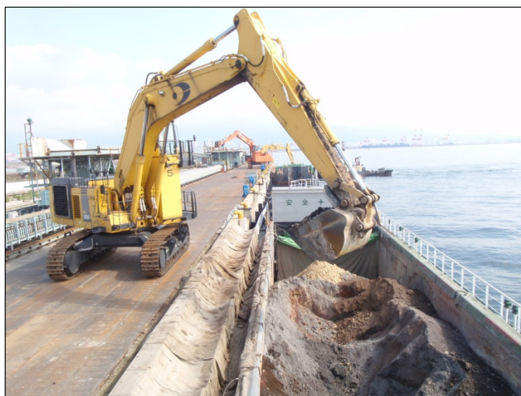
付図8 2期神戸沖埋立処分場における揚陸作業
