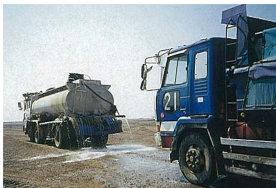
埋立処分場における場内散水
