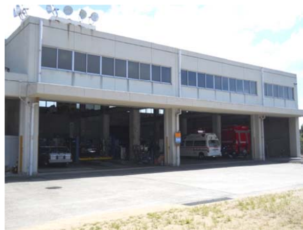
消防局整備工場 (防災センター内)
