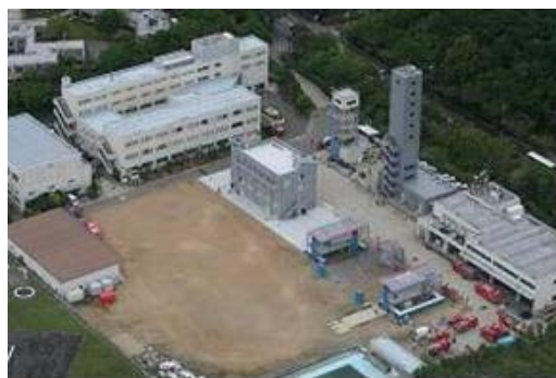
市民防災総合センター
