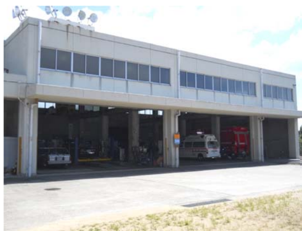
消防局整備工場（防災センター内）
