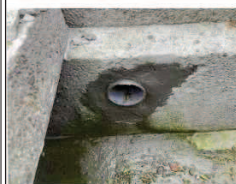
⑥ 排水機接続完了状況
