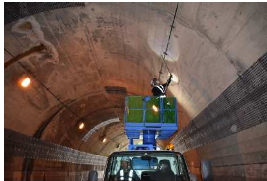
トンネルの点検
