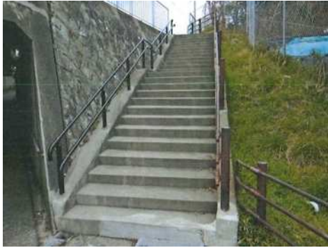
手すりの設置
