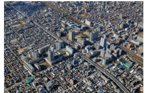
新長田駅南地区市街地再開発事業（現況）
