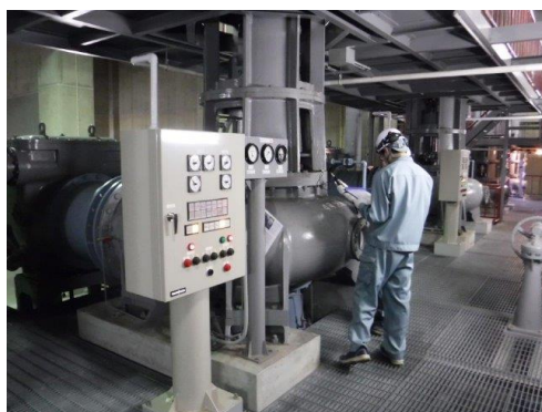
写真 設備の点検・調査作業
