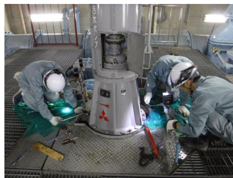
写真 設備の補修・修繕作業
