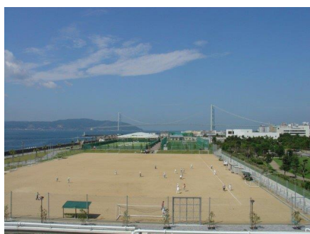
写真 垂水処理場・上部利用施設
