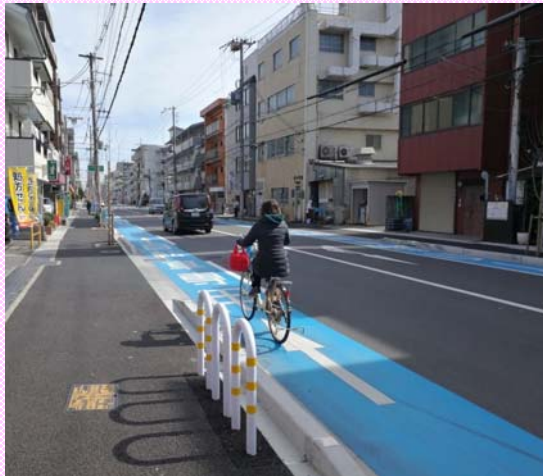
鳴尾御影線 460m整備
