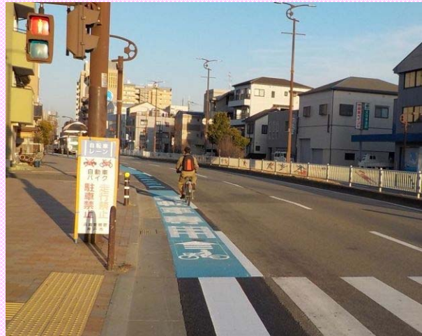
西出高松前池線 260m整備
