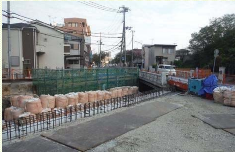
道路拡幅工事(垂水妙法寺線(明神橋))
