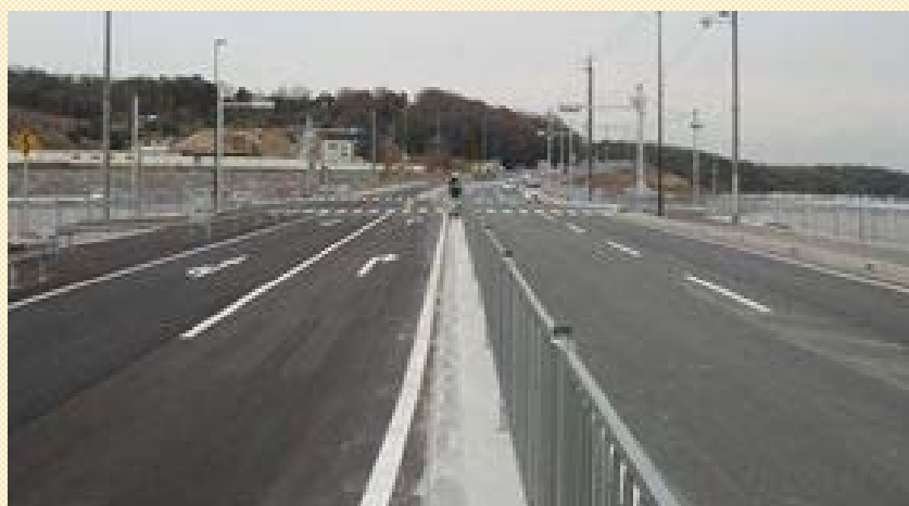
全線開通した国道175号平野拡幅
