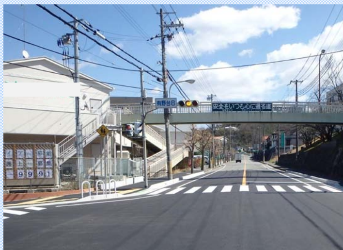
歩道の段差解消(有野台)
