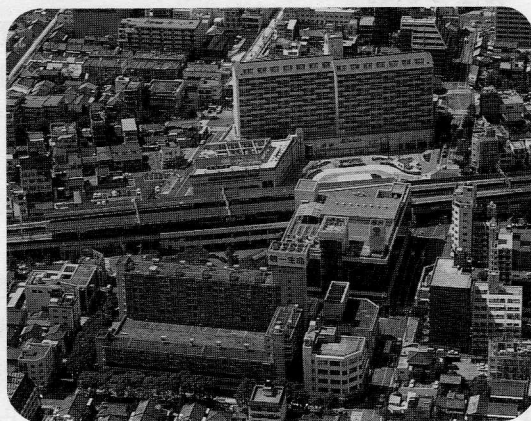
☆六甲道駅前北側再開発完了後
