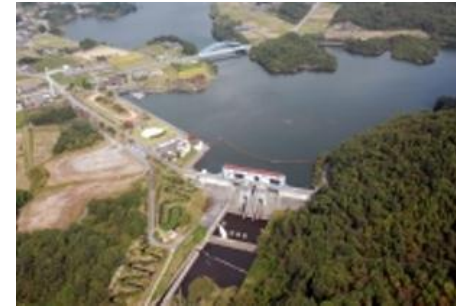
兵庫県用水供給事業 青野ダム(出典:兵庫県HP)
