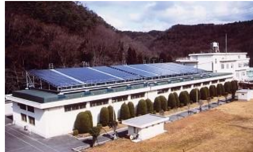
千苅浄水場 (太陽光発電)
