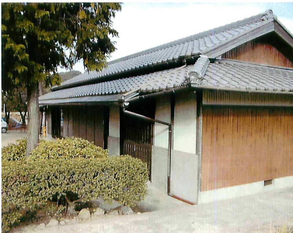
写真2 木津地区の集会所施設（1999.10.26）
