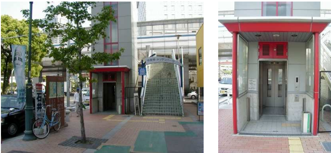
写真3-2-1 エレベーターの併設例
