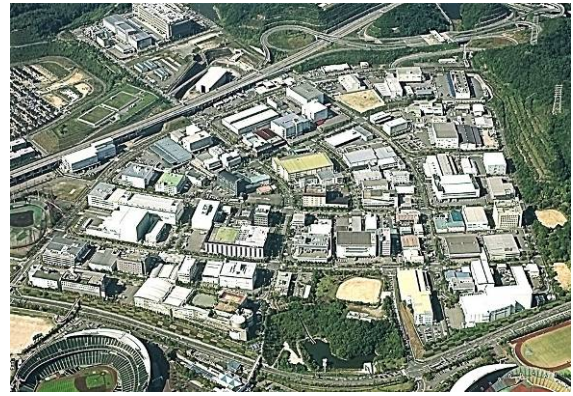
流通業務団地 (須磨区：神戸流通センター)
