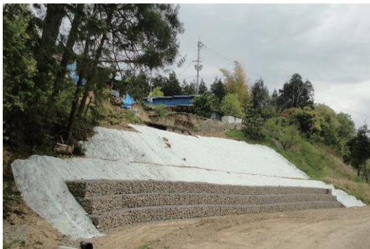
危険がけ応急対策事例
