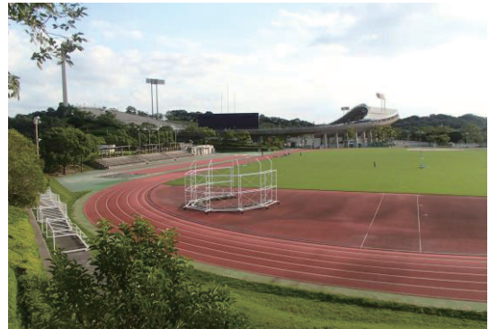
神戸総合運動公園補助競技場のトラック改修
