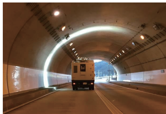
トンネル点検
