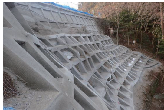
道路法面对策事例
