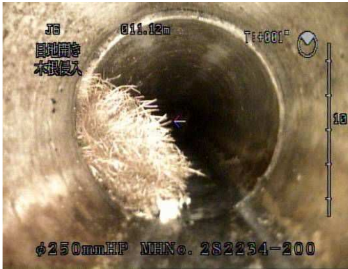
自走式テレビカメラ写真 木根侵入 (R)Aランク 侵入根が流下を阻害
