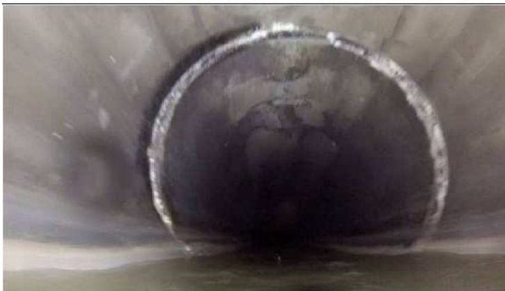
浮流式テレビカメラ写真 浸入水 (D)Bランク 流れている
