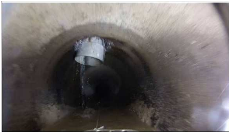
浮流式テレビカメラ写真 取付管突出 (SK)Aランク 本管内に3cm以上
