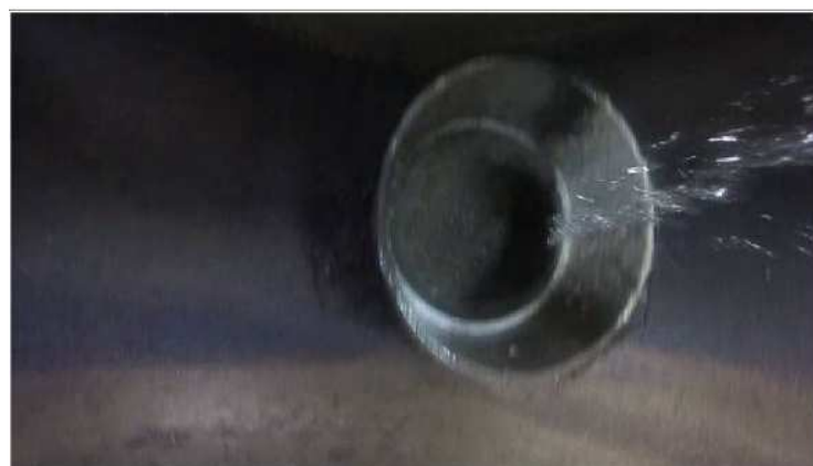
浮流式テレビカメラ写真 取付管突出 (SK)Aランク 本管内に3cm以上
