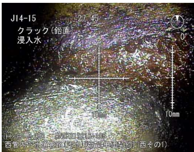
自走式テレビカメラ写真 浸入水 (D)Cランク
